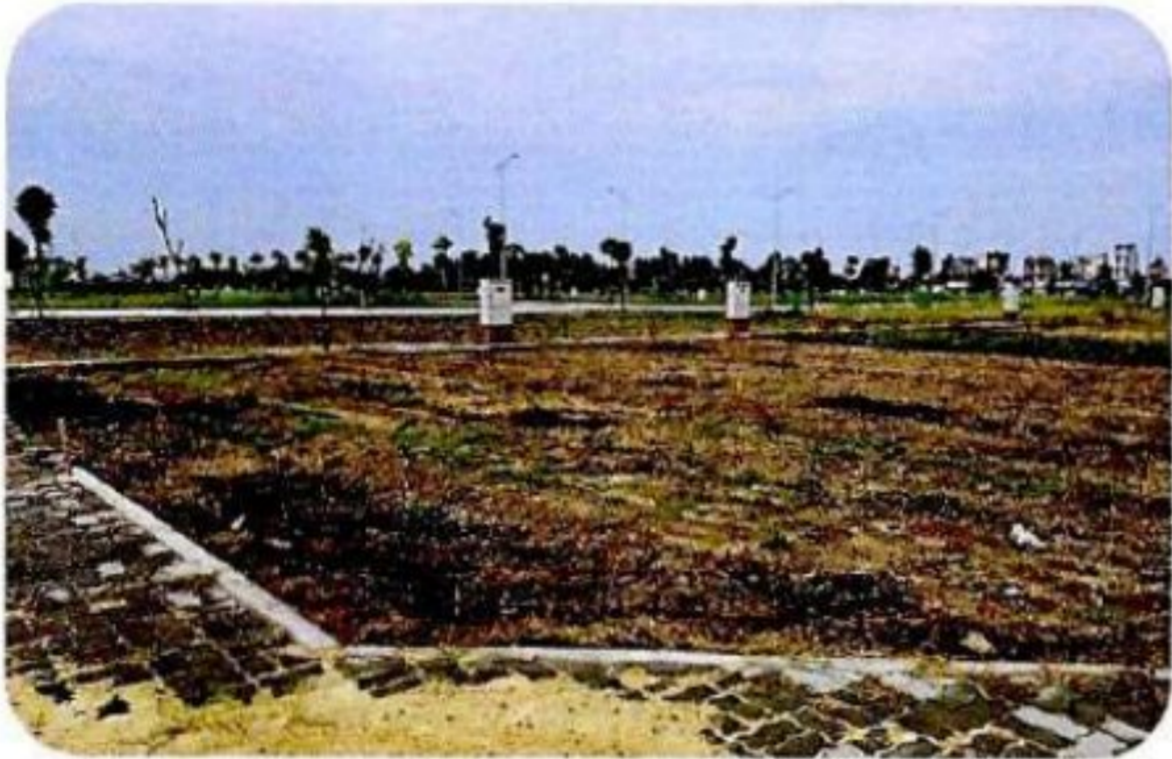
Hình 8.3. San lấp mặt bằng khu đô thị
