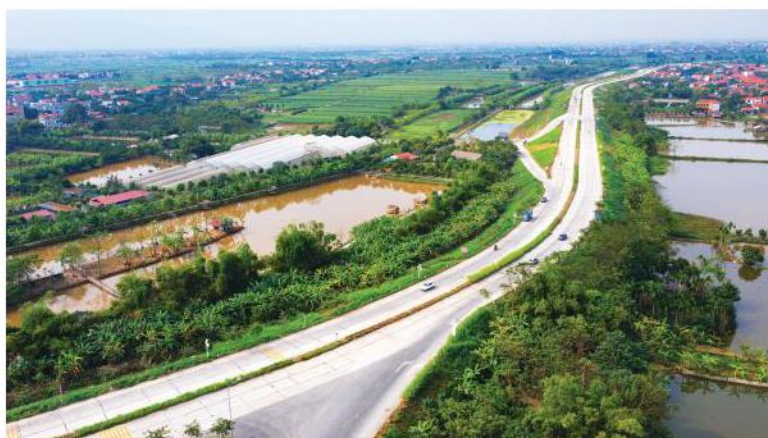
▲ Hình 5. Một đoạn đê sông Hồng
