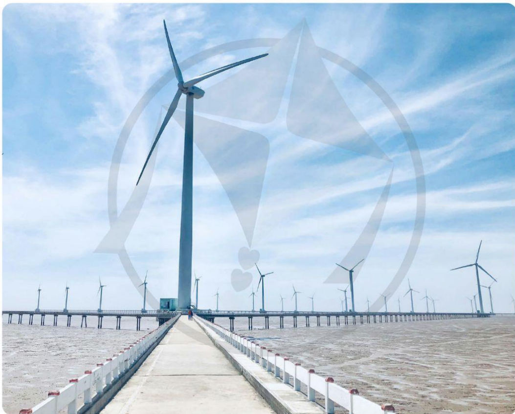
Nhà máy điện gió Bạc Liêu.
