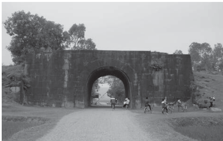
Mặt sau cửa Bắc thành nhà Hồ
