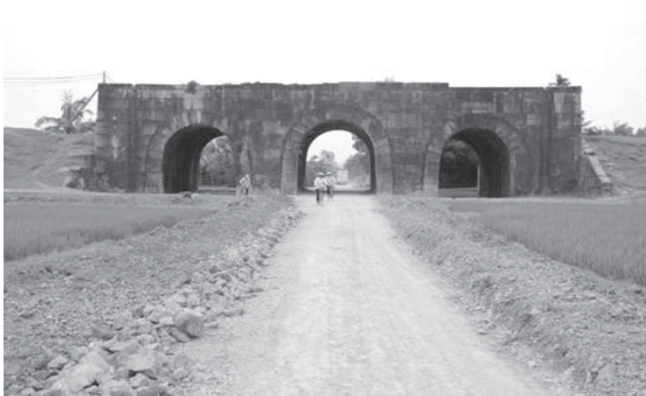
Mặt sau cửa Nam thành nhà Hồ
