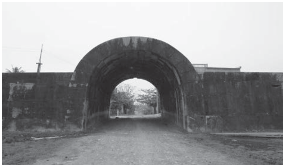
Mặt sau cửa Tây thành nhà Hồ
