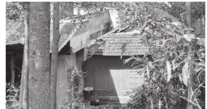
Một căn nhà xây dựng trái phép ở phường Quang Trung. Ảnh: QN
