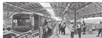
Công trình nhà ga metro đang được hoàn thiện những hạng mục cuối, chuẩn bị cho giai đoạn khai thác. Ảnh: Đ.TRANG
