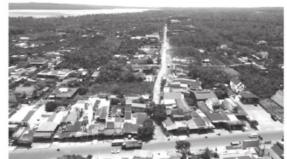
Dự án đầu tư xây dựng đường Hồ Chí Minh đoạn tránh phía đông TP Buôn Ma Thuột phát sinh chi phí giải phóng mặt bằng 332 tỉ đồng. Ảnh: VŨ LONG
