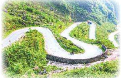
con đường kh★ khu ữ
