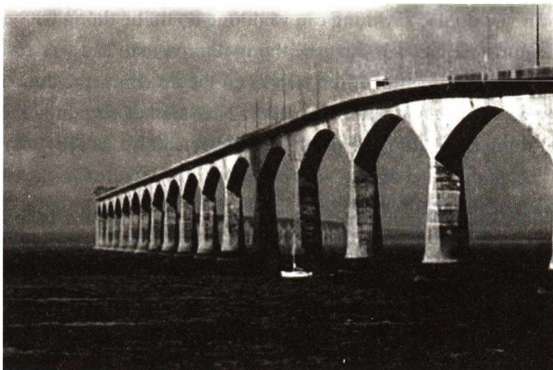
Cầu Confederation ở Canada được xây dựng dựa trên ứng dụng hệ thống định vị toàn cầu
