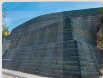
c) Xây bờ kè
