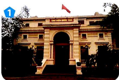
Thư viện Quốc gia, quận Hoàn Kiếm
