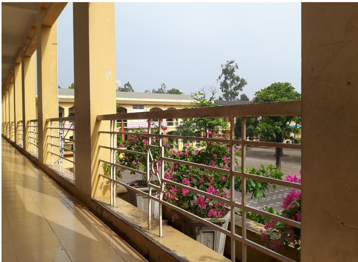
Lan can có chiều cao chưa an toàn
