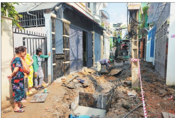
Công nhân thi công hệ thống cống thoát nước tại hẻm 694 Nguyễn Kiệm sau khi được mở rộng.
