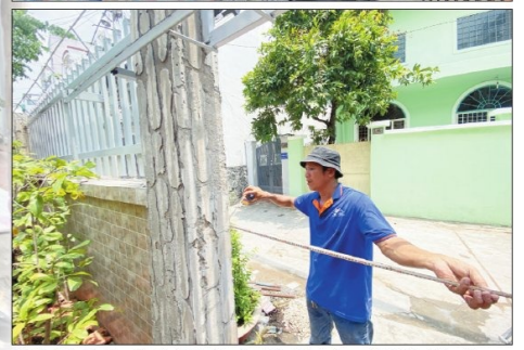
Nhiều hộ dân ở quận Phú Nhuận sửa chữa lại nhà sau khi hiến đất mở rộng hẻm.
