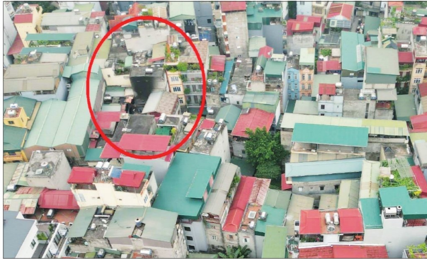
Ngôi nhà bị cháy (nhìn từ trên cao) nằm trong khu dân cư đông đúc tại phường Trung Hòa, quận Cầu Giấy, Hà Nội.
