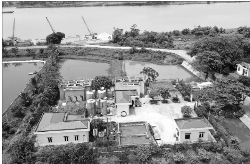
Nhà máy nước sạch liên xã Vũ Bình (Công ty Cổ phần Bitexco Nam Long), đơn vị cung cấp nước cho xã Quang Bình, huyện Kiến Xương, tỉnh Thái Bình.
