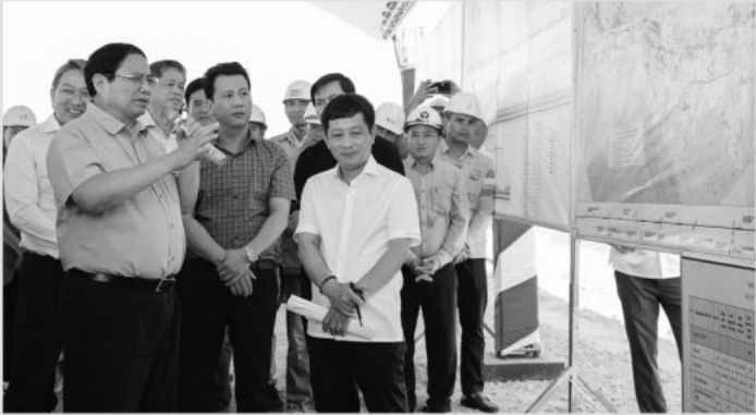
Thủ tướng kiểm tra tình hình thi công dự án cao tốc Vân Phong -Nha Trang (Ảnh: VGP).
