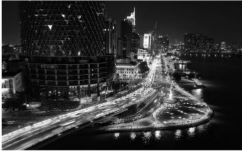
Đề tiết kiệm tối thiểu 30% tổng điện năng tiêu thụ của hệ thống chiếu sáng, Tp.HCM cần 6.000 tỷ đồng thay đèn LED và nâng cấp hệ thống chiếu sáng. (Ảnh: Lao động).
