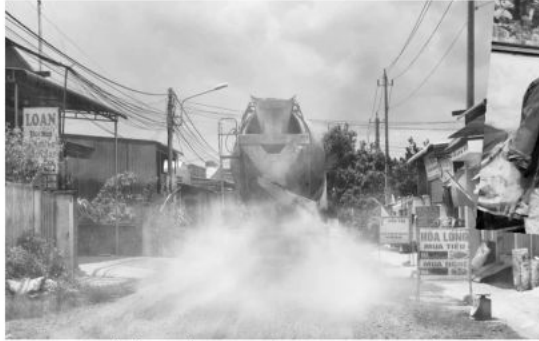
Bụi đất trắng xóa cuốn lên mù mịt mỗi khi các xe chở bê tông tươi chạy qua.
