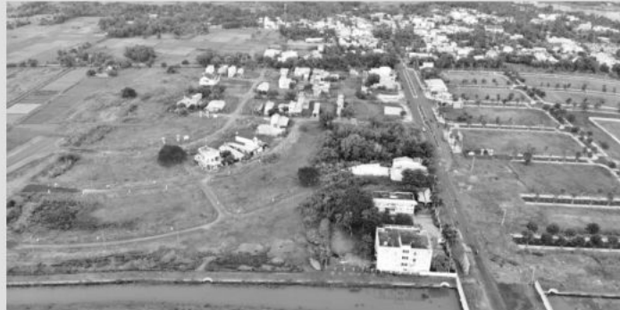
Việc tách thửa, chuyển mục đích sử dụng đất khu vực đất nằm trong quy hoạch đất dân cư xây dựng mới tại Tp.HCM thời gian qua đang gặp nhiều vướng mắc.
