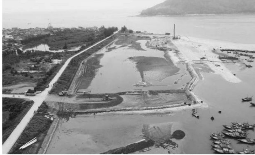
Các dự án đầu tư hạ tầng nghề cá đóng vai trò rất quan trọng trong việc chống khai thác IUU.
