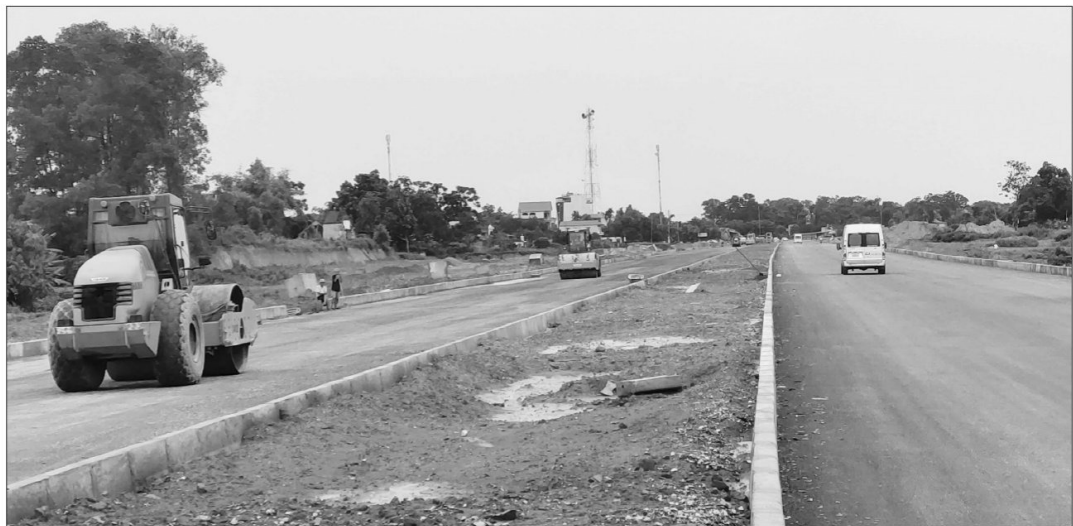
Thi công dự án đường vành đai 5 đoạn qua thị trấn Hương Sơn, huyện Phú Bình (Thái Nguyên).
