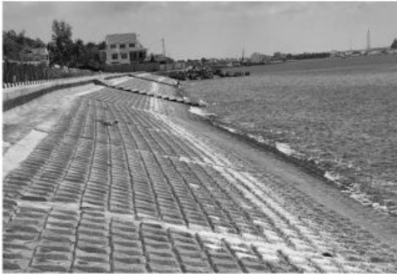
Bình Thuận sẽ đầu tư dự án kè chống xâm thực, bảo vệ bờ biển phía Bắc đảo Phú Quý trị giá 300 tỷ đồng.
