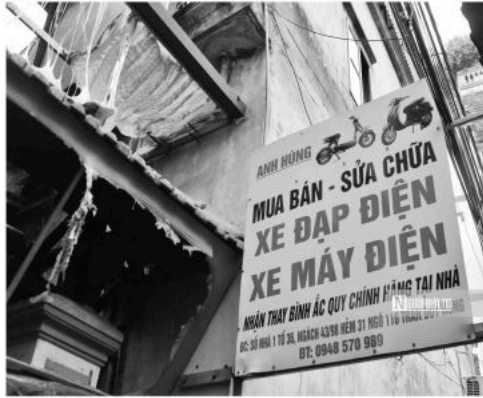
Tầng 1 của căn nhà là nơi mua bán, sửa chữa xe đạp điện, xe máy điện (Ảnh: Đặng Thủy).
