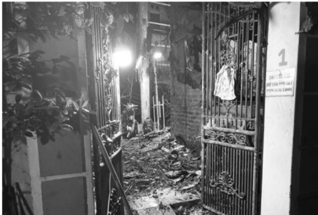
Hiện trường vụ cháy.
