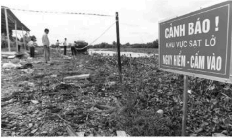
Chính quyền địa phương đã căng dây, lắp biển cảnh báo khu vực sạt lở nguy hiểm. (Ảnh: Báo Giao Thông).
