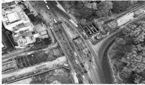
Công trình đường nối Trần Quốc Hoàn - Cộng Hòa tại cửa ngõ sân bay Tân Sơn Nhất (kết nối trực tiếp nhà ga T3) là một trong những công trình trọng điểm của Tp.HCM. (Ảnh: Dân Việt).
