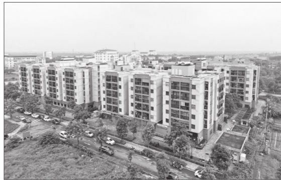
Khu nhà ở xã hội huyện Mê Linh (Hà Nội) vừa được đưa vào sử dụng.
