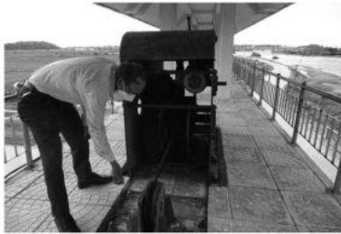
Không có điện nên việc nâng hạ các cửa van ở cống ngăn mặn sông Rô phải vận hành bằng tay. (Ảnh: Báo Lao động).
