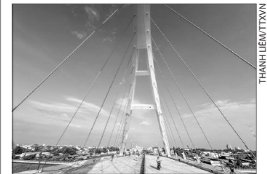
Cầu Trần Hoàng Na được thông xe sau hơn 3 năm thi công.
