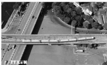
Đoạn trên cao của dự án metro Nhổn-Ga Hà Nội đã được cấp chứng nhận an toàn hệ thống. (Ảnh: TTXVN).
