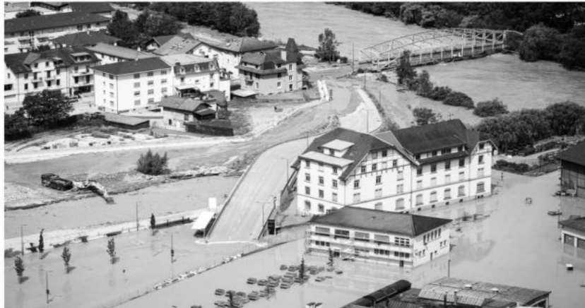
Nhiều công trình đã bị phá hủy bởi mưa lũ dữ dội. (Ảnh: EPA-EFE).
