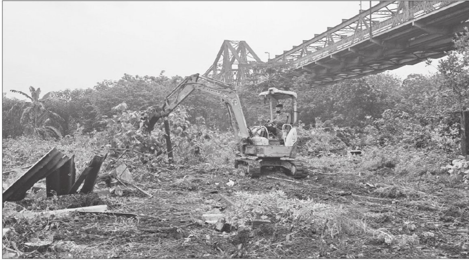
Giải tỏa, thu dọn, chặt hạ cây dại, thu gom vận chuyển phế thải, rác thải bị đổ trộm tại khu vực gầm cầu và giáp cầu Long Biên.
