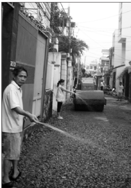
Con đường đang ñược thi công
