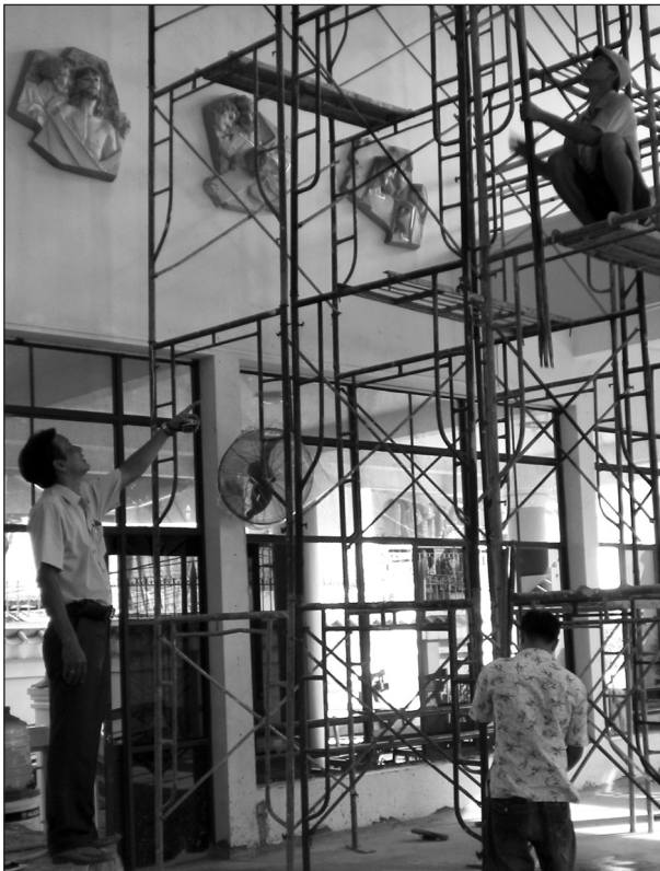
Anh Bửu Cọp (trái) đang hướng dẫn công nhân thi công lắp đặt giàn giáo ở Trung tâm TĐTT quận 11
