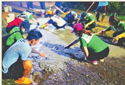
Các tình nguyện viên tham gia Dự án "Tuyến đường bình yên" sửa chữa tuyến đường tại tỉnh Gia Lai tranh thủ làm việc trong đêm.
