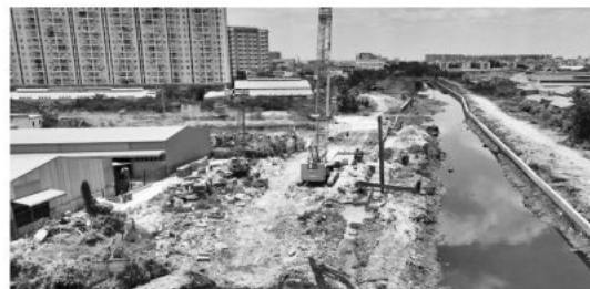
Một dự án do nhà thầu Thuận An thi công tại Tp.HCM.
