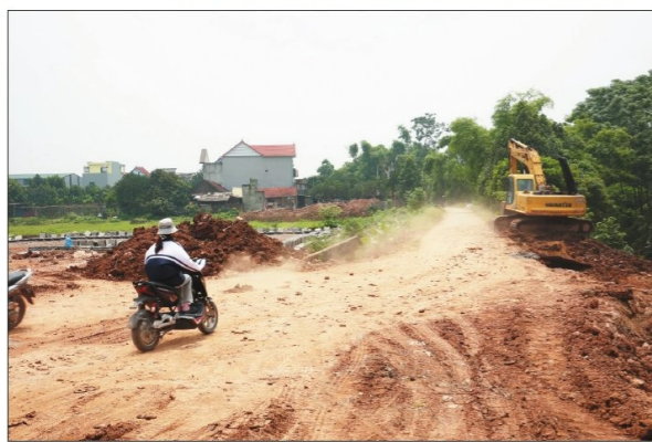
Máy móc thi công lẫn cả phần đường dân sinh.
