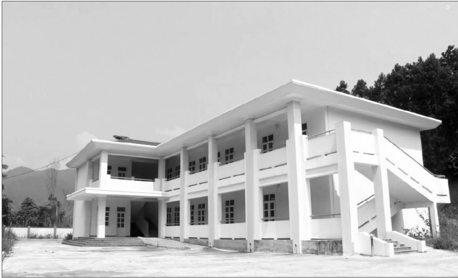
Công trình trường học bản Ka Ai xây xong đã 3 năm vẫn chưa bàn giao để đưa vào sử dụng.
