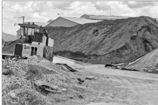
Bãi nguyên liệu của nhà máy phân hữu cơ vi sinh chỉ được che chắn sơ sài.
