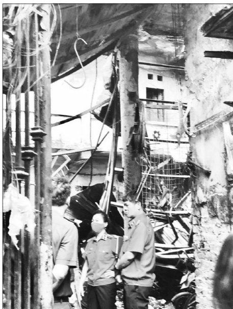
Hiện trường vụ cháy tại số 1 ngõ 43/98 đường Trung Kính (phường Trung Hòa, quận Cầu Giấy, Hà Nội) khiến 14 người tử vong.
