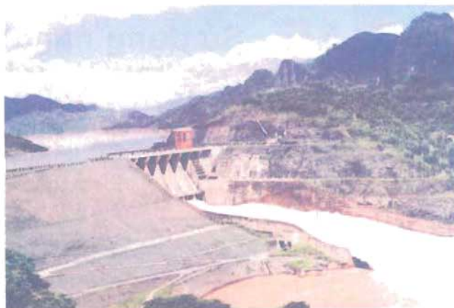
④ Nhà máy thủy điện
