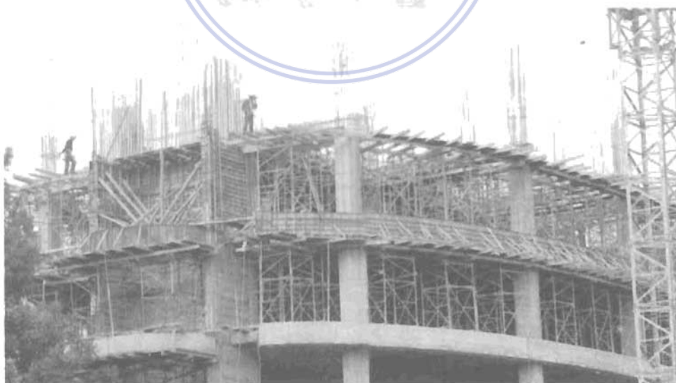
③ Đổ bê tông cốt thép
