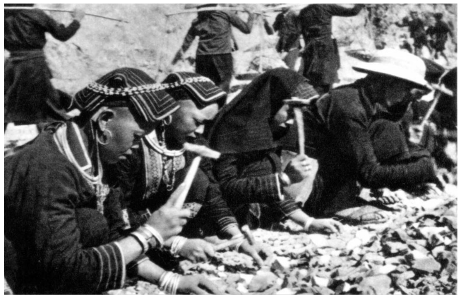
Con đường lên Điện Biên Phủ dài 300 kilômét được xây dựng bằng tay.
