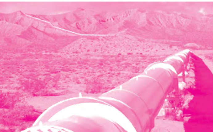
Đường ống nước khổng lồ đưa nước đi ngang qua sa mạc Mojave, Hoa Kỳ.
