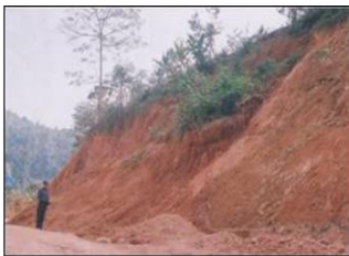
Trượt lở đất trong lớp vỏ phong hoá trên tuyến đường 4A qua xã Thái Cường, Thạch An, tỉnh Cao Bằng
