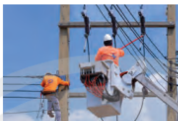
b) Thợ lắp đặt đường dây điện
