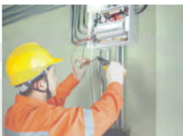
b) thợ lắp điện cho toà nhà
