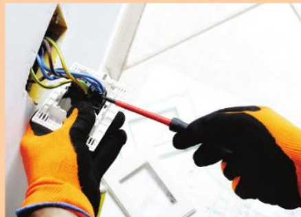
b) Lắp đặt thiết bị điện
