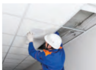
c) thợ lắp điện cho toà nhà
