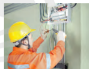
d) Lắp đặt mạng điện trong nhà
