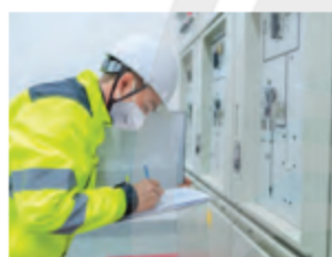
a) Vận hành hệ thống điện
