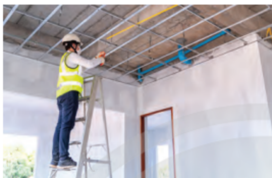
Hình 7.1. thợ lắp điện cho toà nhà
