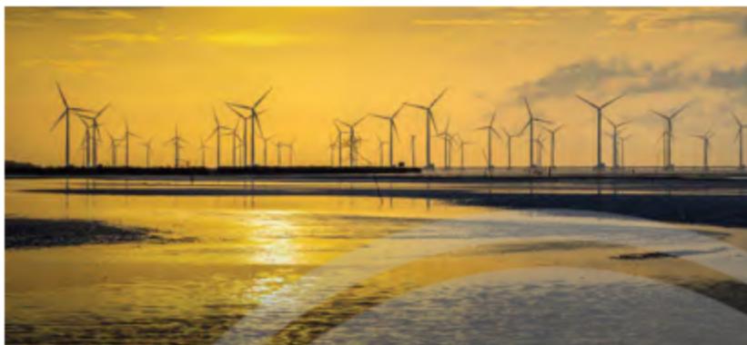
▲ Hình 15.2. Nhà máy điện gió Bạc Liêu
