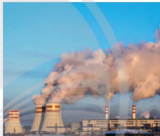
▲ Hình 14.3. Nhà máy nhiệt điện than đang thải khói bụi ra môi trường
