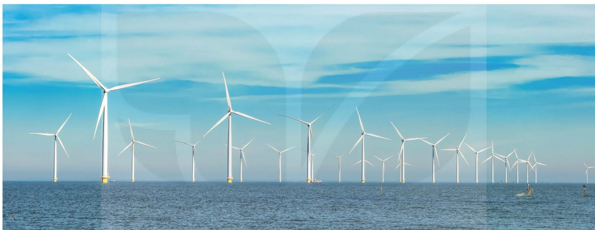
Hình 17.3 Tua-bin gió được lắp đặt ở biển
