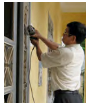
Sửa cửa trước khi lắp điều hòa
