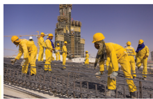
Xây dựng công trình
