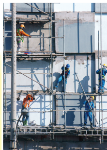
Công trường xây dựng
