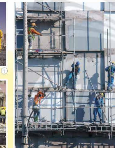
Công trường xây dựng
