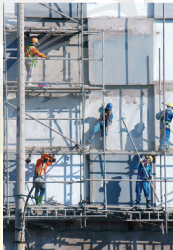
Công trường xây dựng
