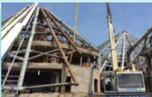
Công trình đang tiến hành xây dựng ⑤
