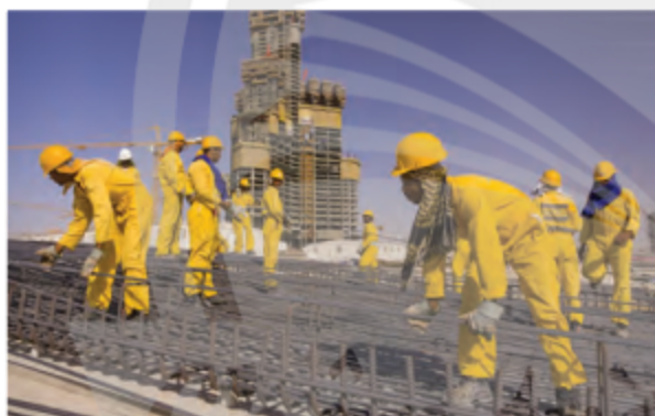
Xây dựng công trình
