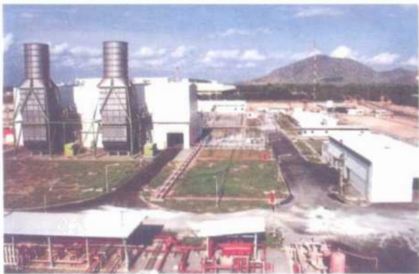
Nhà máy Nhiệt điện Tuabin Khí Phú Mỹ II
