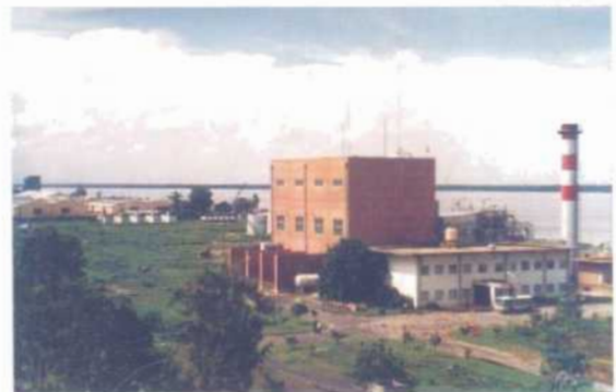
Nhà máy Nhiệt điện Cần Thơ
