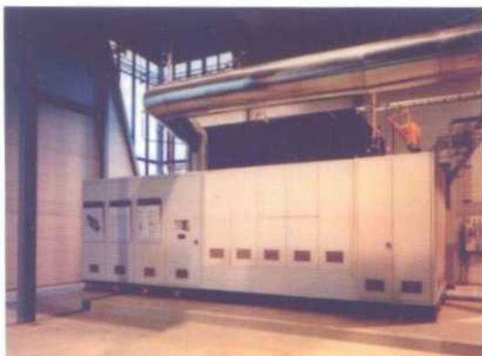
Môđun phát điện bằng pin nhiên liệu
