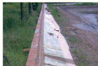
d) Ao nổi, kê bờ
