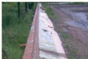
d) Ao nổi, kê bờ
